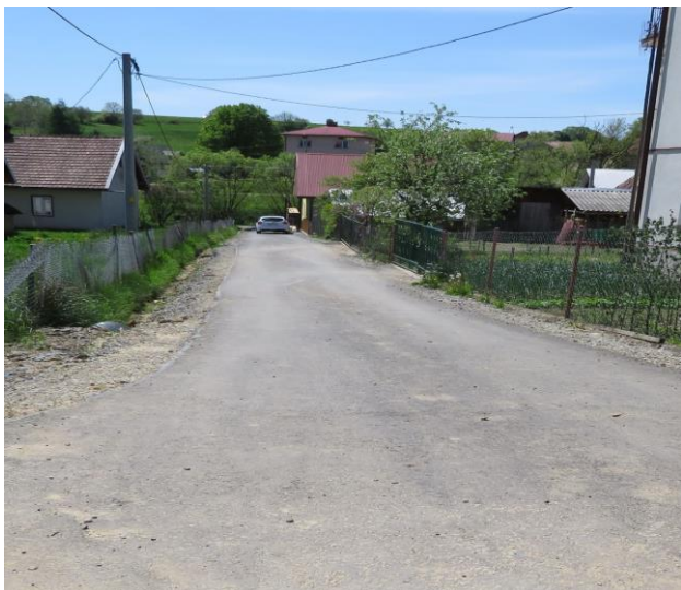
Przebudowa drogi wewnętrznej dz. nr ew. 155 i 149/1 w m. Hoczew (93 mb z tego 75 mb nawierzchni asfaltowej) – 41 262,71 zł.
