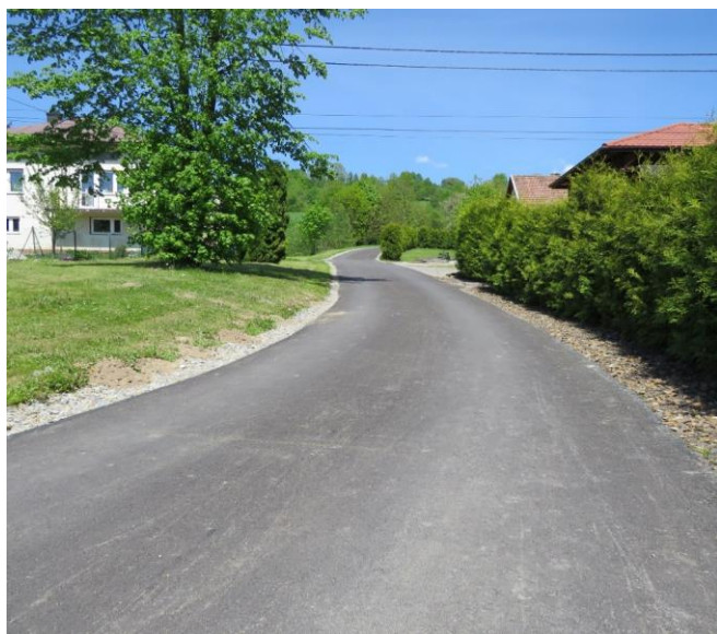
Przebudowa drogi wewnętrznej dz. nr ew. 293 w m. Manasterzec (77 mb)– 32695,80 zł.
