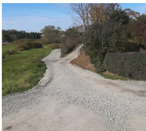
Remont drogi wewnętrznej dz. nr ew. 810 – Jankowce (83 mb)– 15 394,09 zł.
