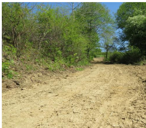
Remont drogi wewnętrznej na dz. nr ew. 309 w m-ci Glinne (niwelacja drogi na dł. 100 mb, karczowanie pniaków, oczyszczenie rowu odwadniającego, wbudowanie 2 szt. przepustów fi 60 i fi 80)– 16 938,50 zł.
