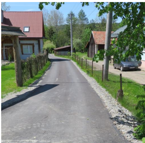
Przebudowa drogi wewnętrznej dz. nr ew. 19 w m. Łukawicy (65 mb)– 25954,06 zł.
