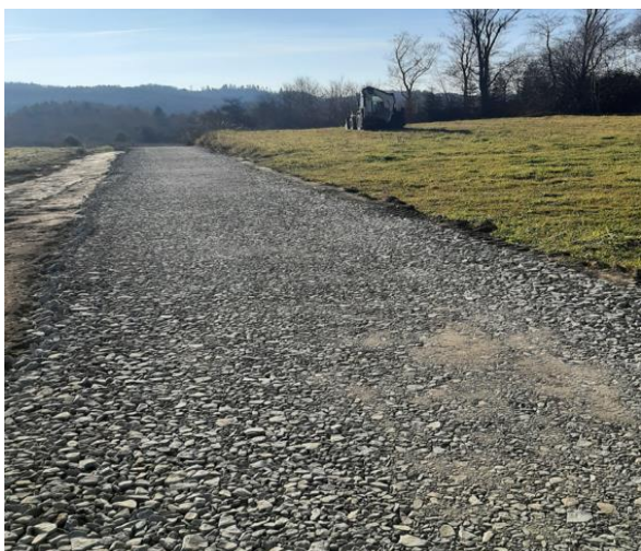
Przebudowa drogi wewnętrznej dz. nr ew. 1/2 i 129/2 w m-ci Dziurdziów (80 mb) – 9 169,65 zł.
