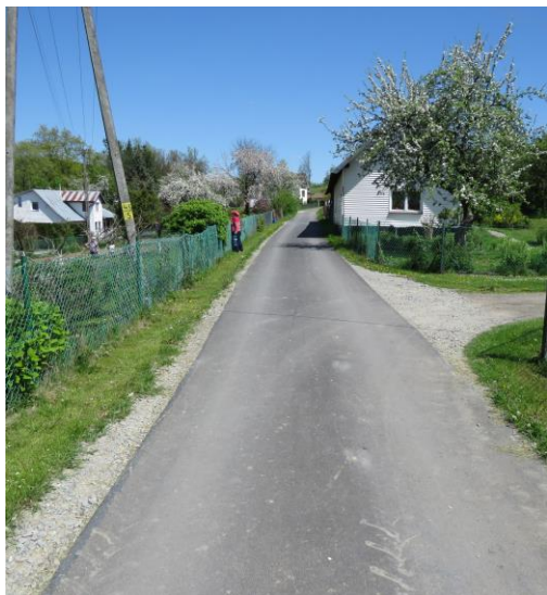
Przebudowa drogi wewnętrznej dz. nr ew. 271 w m. Średnia Wieś (170 mb) – 36 666,30 zł.
