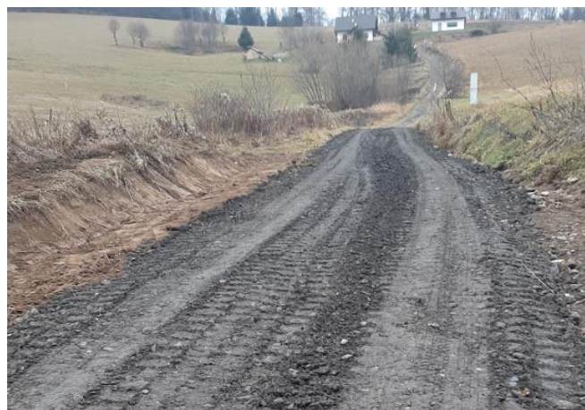
Remont drogi wewnętrznej dz. nr ew. 41 i 687 w m-ci Hoczew (115 mb) – 10 350,00 zł.
