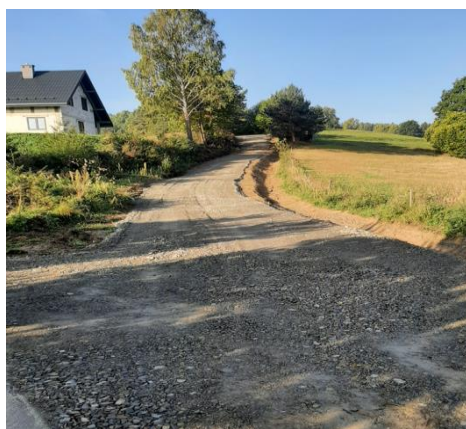
Remont drogi wewn. dz. nr ew. 240/ 1 Dziurdziów(140 mb)– 18 320,01 zł.
