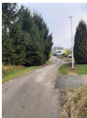
Budowa oświetlenia drogi gminnej dz. 169/2, 168/1, 167/2, 162/1 w m-ci Postołów – 25 522,50 zł.
