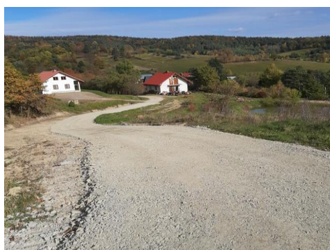
Remont drogi wewnętrznej dz. nr ew. 151/ 1 w m. Dziurdziów (80 mb) – 8 464,59 zł.
