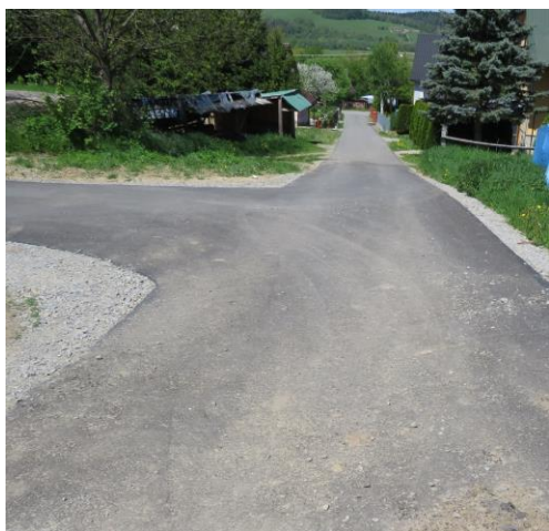
Przebudowa drogi wewnętrznej (dz. nr ew. 134) w m-ci Średnia Wieś (23 mb) – 8 346,96 zł.
