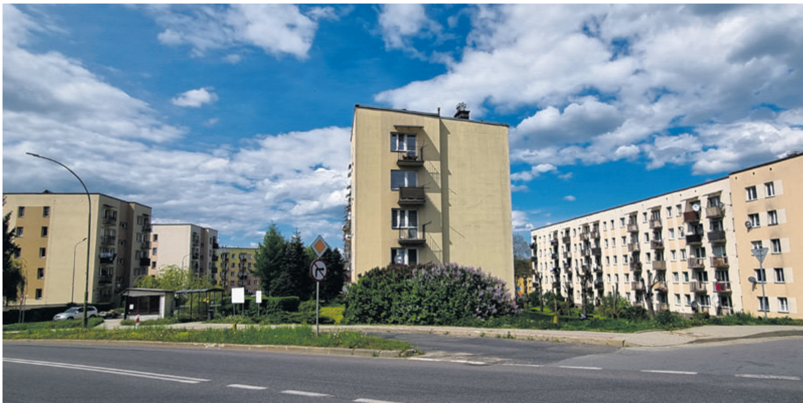
▲ Na Osiedlu Smolki rozpoczęła się przebudowa ulic za ponad 3 mln złotych
