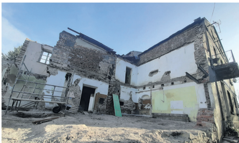
▲ Prace renowacyjne przy budynku dawnej świątyni ormiańskiej w Lesku
