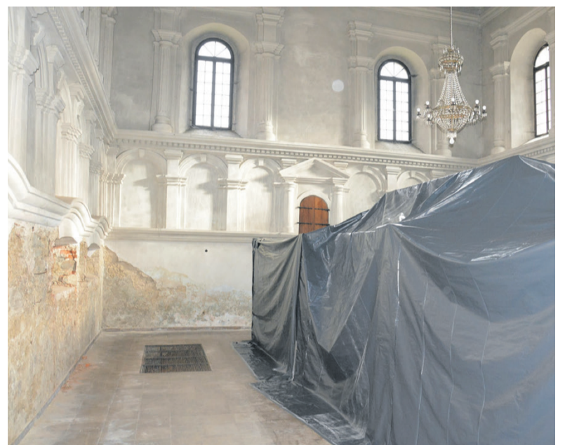
▲ W środku zabytku częściowo skuto zawilgocone tynki i wykonano nowe wprawy
