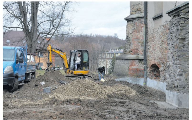
▲ Wokół synagogi został wykonany drenaż odwadniający
