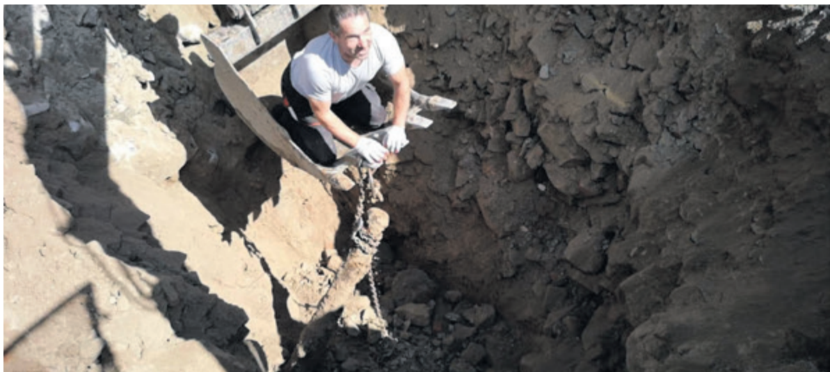
▲ Paweł Murawski szef firmy wykonującej prace, natychmiast wsiadł do łyżki koparki i zjechał w dół, tam obwiązał odkrytą lufę łańcuchem
