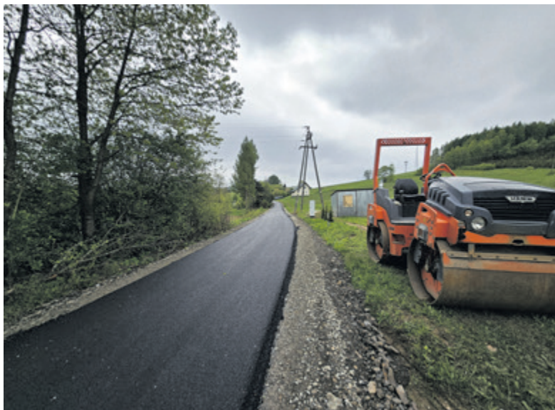
▲ W Bachlawie na długości 230 metrów wyłożona została nakładka z masy bitumicznej na jednej z dróg gminnych
