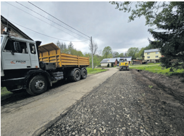
▲ Trwają prace przygotowawcze do położenia asfaltu w Dziurdziowie. Na wąskiej drodze wykonana została także mijanka
