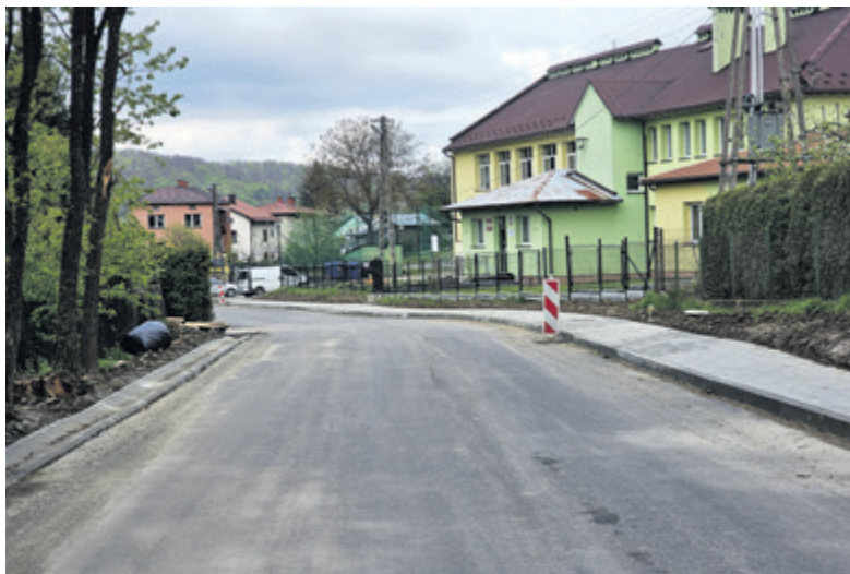
▲ Na ukończeniu jest budowa chodnika oraz poszerzenie drogi przy szkole podstawowej w Średniej Wsi
