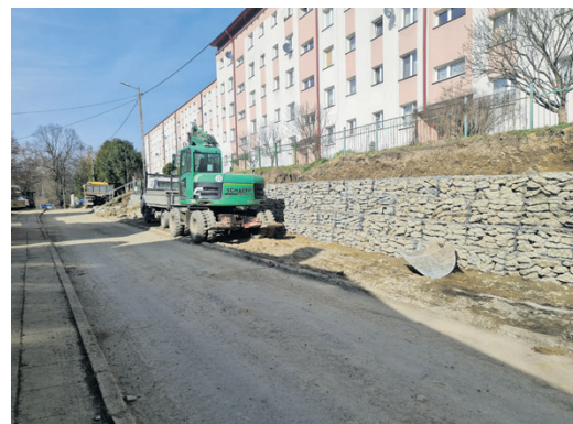
▲ Na ulicy Kmity wykonawca buduje nowy mur oporowy i poszerza miejsca postojowe
