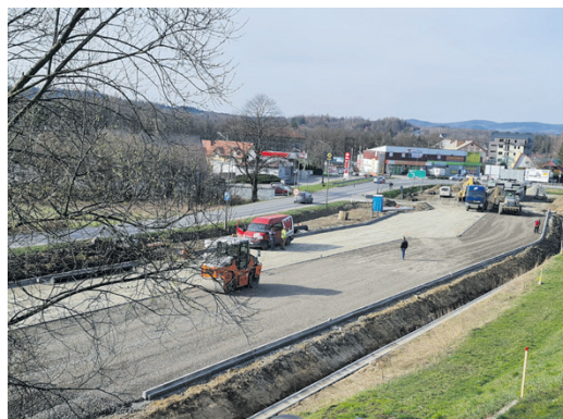
▲ Na parkingu koło ronda układane są drenáže, krawężniki i podbudowa pod kostkę betonową
