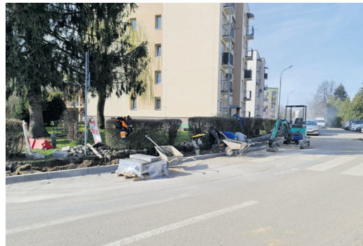
▲ Nowe chodniki wykonywane są przy blokach nr 1 i 3 na Smolkach. Naprzeciwko powstaną nowe miejsca postojowe.
