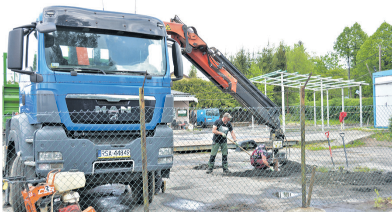
▲ Przebudowa leskiego PSZOK-u
