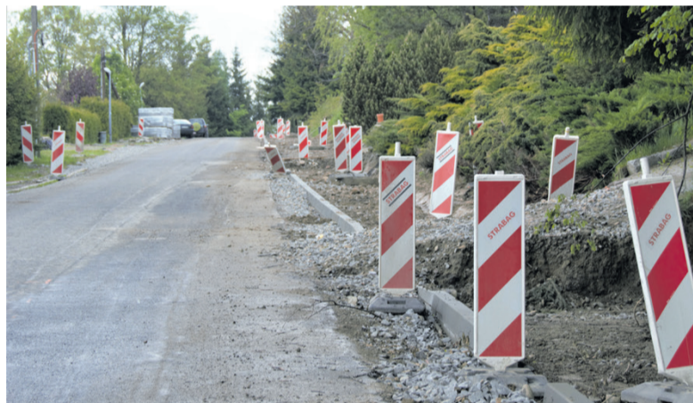
▲ Przebudowa ul. Widokowej.
