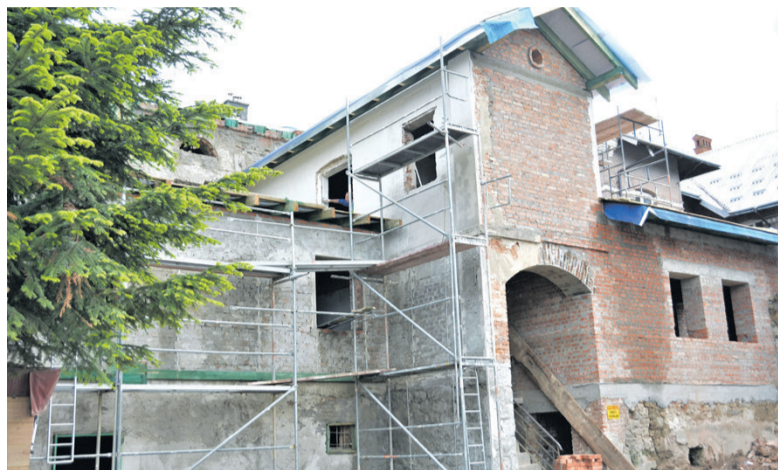
▲ Remont budynku przy Placu Konstytucji 3 Maja
