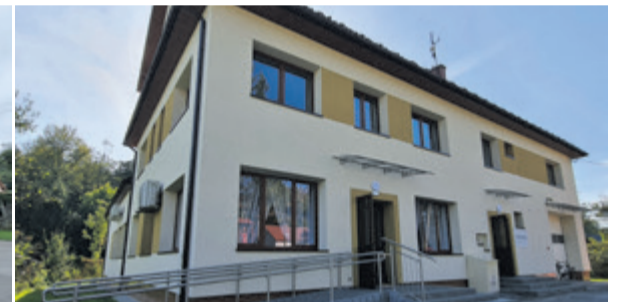
▲ Budynek po modernizacji
