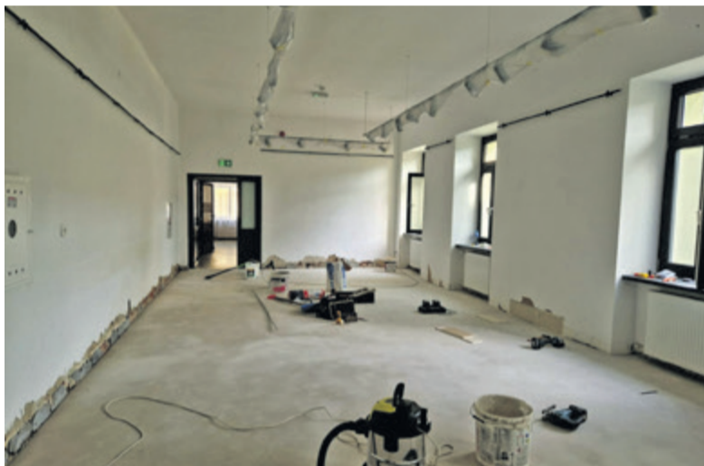
▲ Prace remontowe w Galerii BDK
