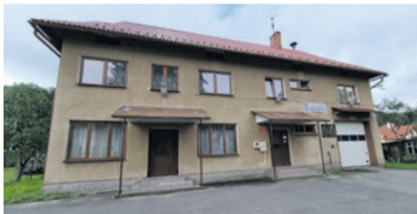
▲ Budynek przed modernizacją
