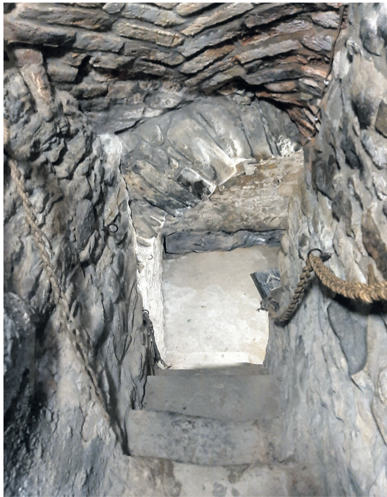
▲ Do lochu pod wieżą prowadzi wąskie przejście
