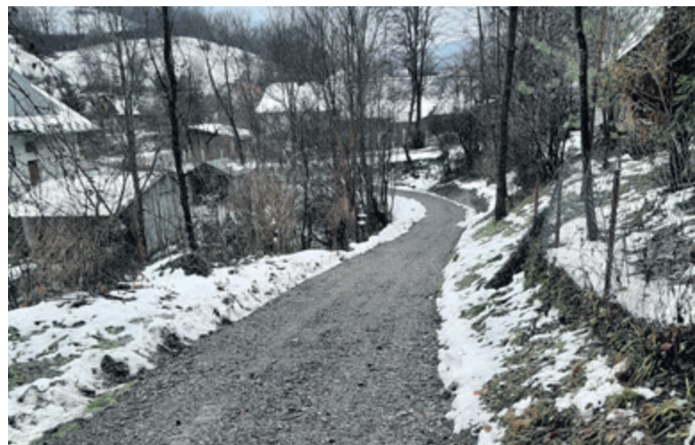
▲ W Średniej Wsi korytowano i utwardzono kruszywem dwa odcinki dróg
