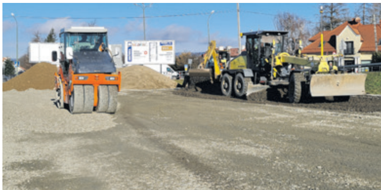
▲ Parking przy rondzie ma być gotowy najpóźniej za 9 miesięcy
