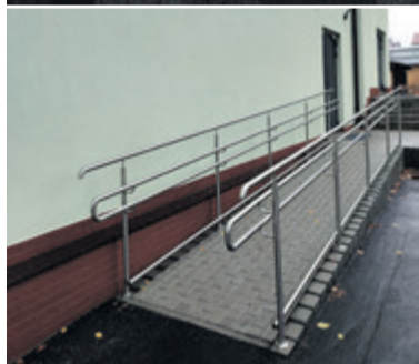
▲ Dla osób niepełnosprawnych na zewnątrz budynku zbudowano pochylnię, a w środku do dyspozycji jest transporter schodowy
