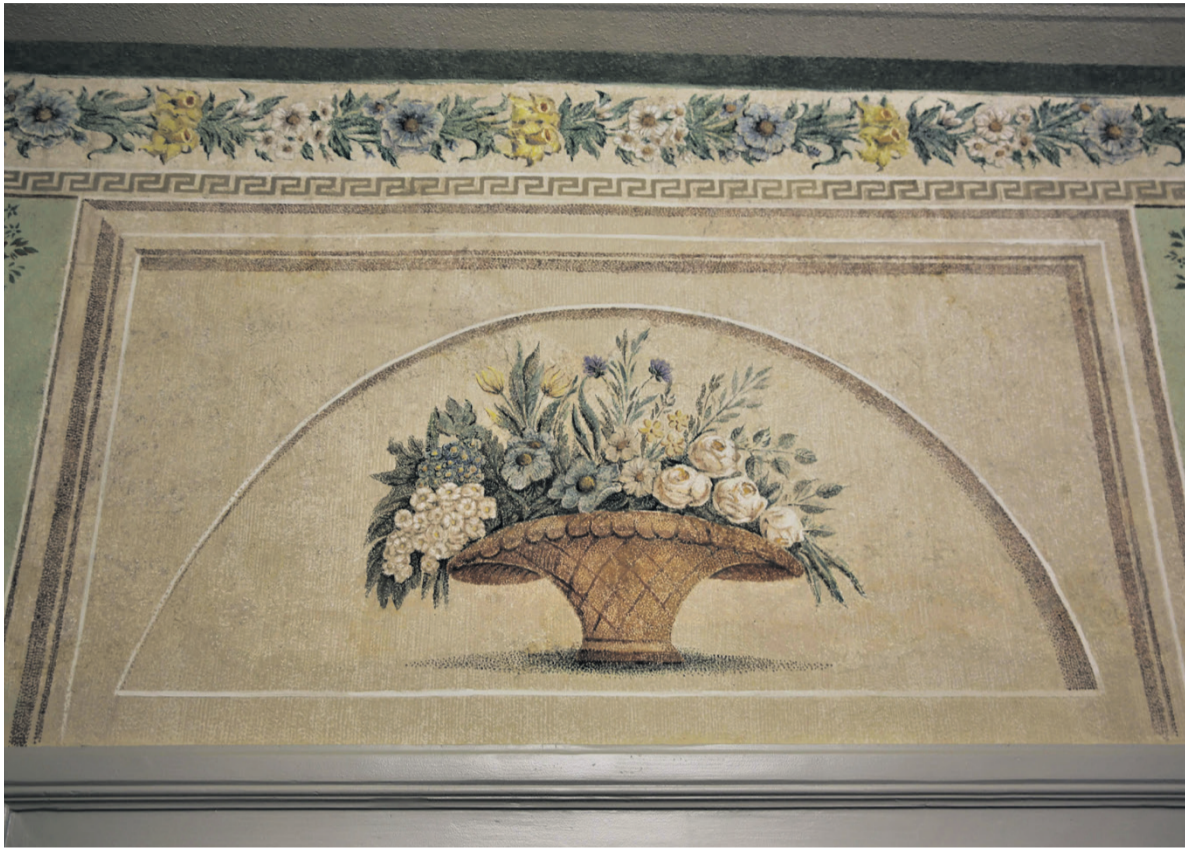
▲ W kamienicy odsłonięto polichromie, które poddano pełnej konserwacji w zakresie techniczno-technologicznym i artystyczno-estetycznym
