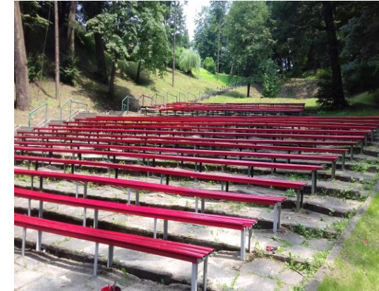
14. Modernizacja siedzisk w Amfiteatrze w Lesku – 13 636,19 zł
