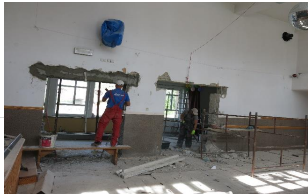
35. „Przebudowa świetlicy wiejskiej w Hoczwi” – 20 426,49 zł , w tym 9 764,00 zł z Podkarpackiego Programu
