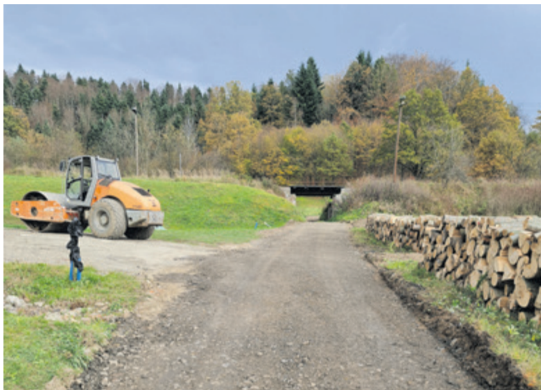
▲ Prace remontowe na drogach gminnych
