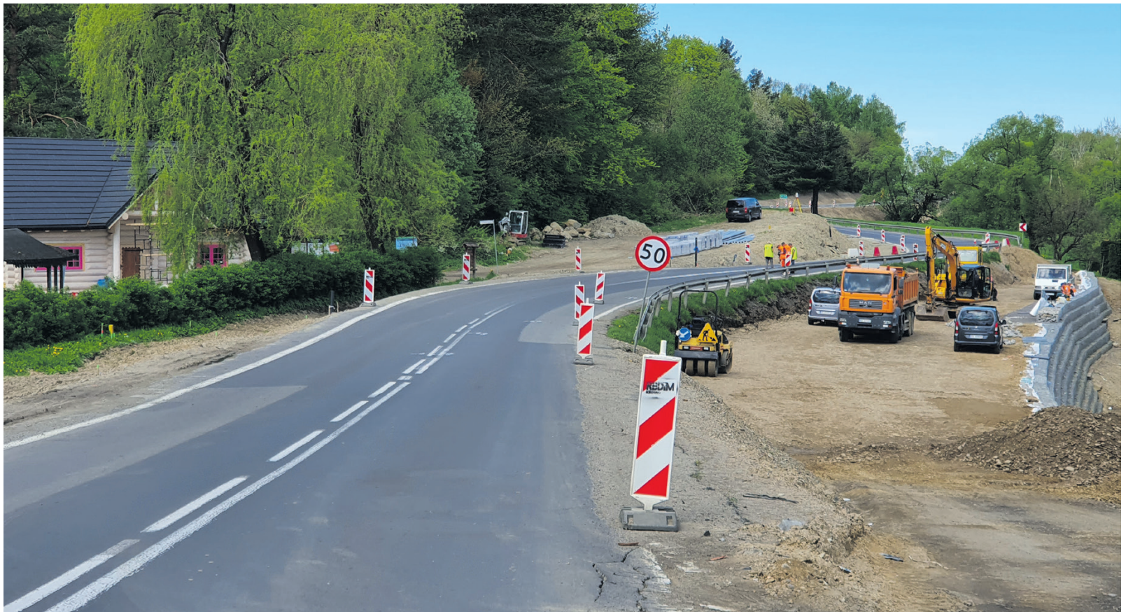
▲ W miejscu budowy lewoskrętu do pomnika przyrody „Kamień Leski” w Glinnem, GDDKiA zaplanowała korektę przebiegu sytuacyjnego DK84
