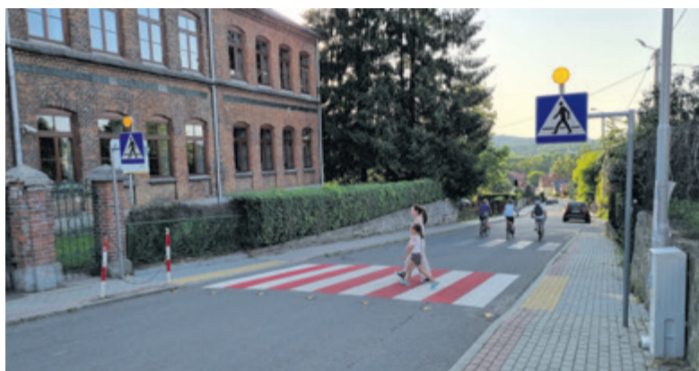
▲ W nawierzchnię asfaltową wbudowane zostały aktywne „kocie oczka”, wymalowano też pasy grubowarstwowe w kolorze czerwono – białym
