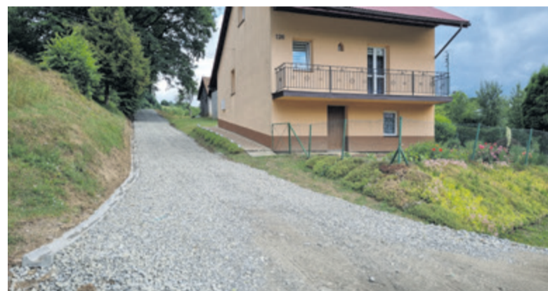
▲ Na drodze w Jankowcach ułożono m.in. podbudowę oraz nawierzchnię z tłucznia kamiennego
