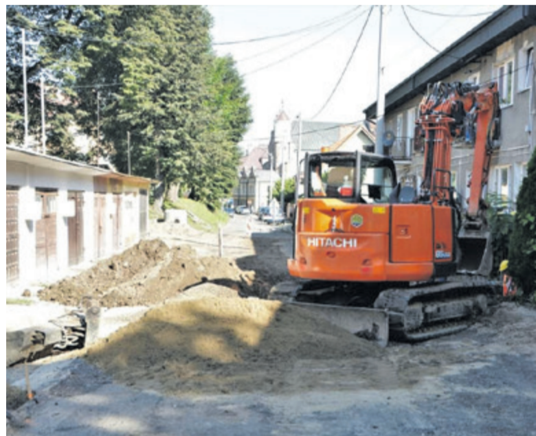
▲ Prace przy ul. Berka Joselewicza
