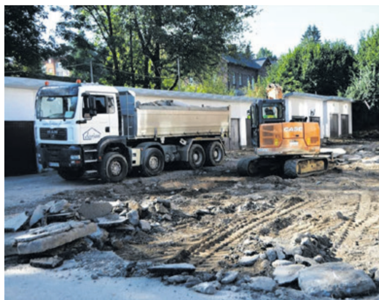
▲ Prace przy ul. Wincentego Pola
