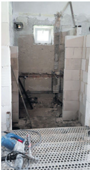
▲ Remontowane toalety w świetlicy wiejskiej w Bezmiechowej Górnej
