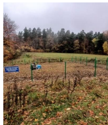
Zdjęcia 33.,34 Prace przy modernizacji SUW Dziurdziów
