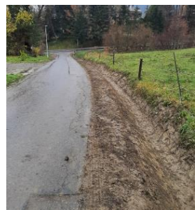
Zdjęcie 11. Oczyszczenie rowu z namułu przy drodze prowadzącej do kościoła w m. Postołów.
