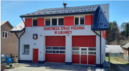
Zdjęcie 1 Budynek remizy OSP Łukawica po rozbudowie
