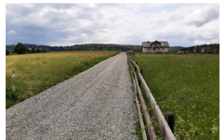
Zdjęcie 6. Remont drogi wewnętrznej dz. nr ewid. 54 w m-ci Weremień
