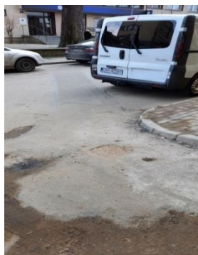
Zdjęcie 37. Odcinek kanalizacji sanitarnej przy ul. Ossolińskich w Lesku
