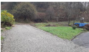
Zdjęcie 19. Remont drogi wewnętrznej na dz. nr ewid. 389 w m-ci Łączki.
