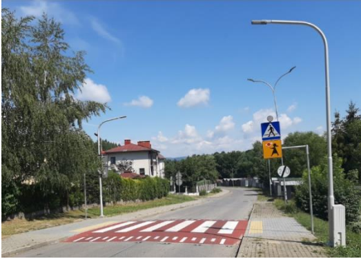
Zdjęcie 8. Wybudowane przejście na ul. Słowackiego w Lesku.
