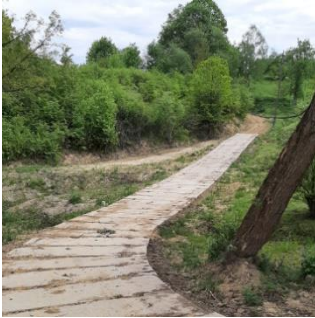
Zdjęcie 5. Remont drogi wewnętrznej na dz. nr ew. 309 w m-ci Glinne.
