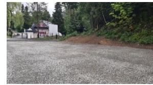
Zdjęcie 20. Remont drogi przy Kamieniu Leskim.
