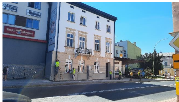
Zdjęcie 39. Budynek przy ul. Rynek 15 po remoncie elewacji
