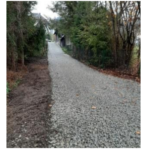
Zdjęcie 12. Remont drogi wewnętrznej na dz. nr ewid. 40 w m-ci Łukawica.
