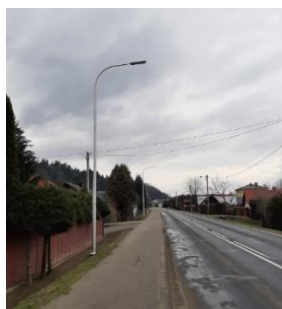
Zdjęcie 44-45. Budowa oświetlenia ulicznego w miejscowości Huzele.
