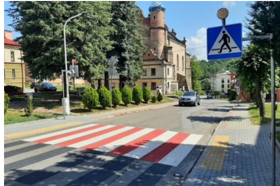
Zdjęcie 9. Wybudowane przejście na ul. Moniuszki w Lesku.
