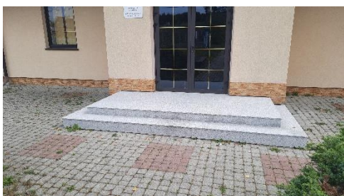
Zdjęcie 31. Widok schodów po remoncie
