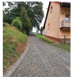
Zdjęcie 22. Remont drogi wewnętrznej dz. nr ewid. 808 w m-ci Jankowce
