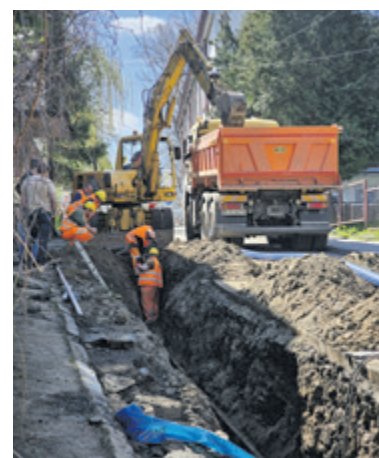
▲ Prace rozpoczęły się wiosną i potrwają do jesieni
