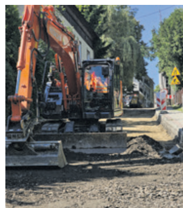
▲ Po rozkopach i wymianie rur, cała nawierzchnia ulic jest zrywana i odbudowywana
