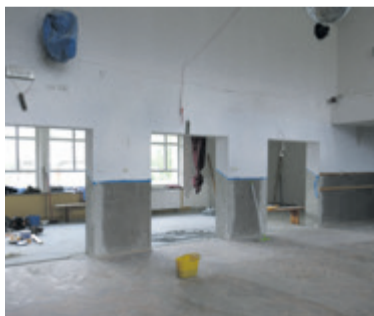
▲ Przebudowana – powiększona sala świetlicy w Hoczewi (zdjęcie podczas remontu)
