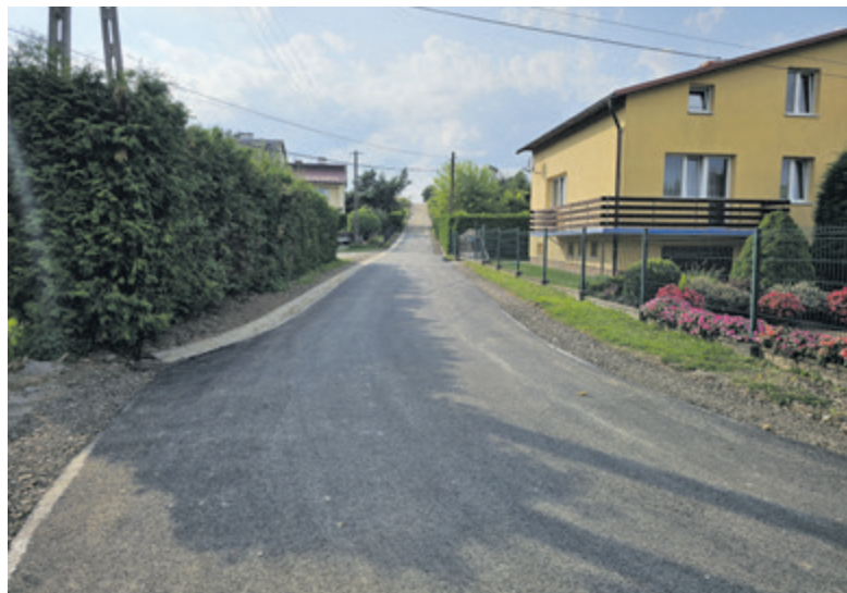
▲ W górnej części Średniej Wsi Gmina Lesko wykonała gruntowny remont drogi. Powstała podbudowa, ułożony został asfalt a wzdłuż ulicy wody opadowe odprowadzają do studzienki ściekowej korytka
