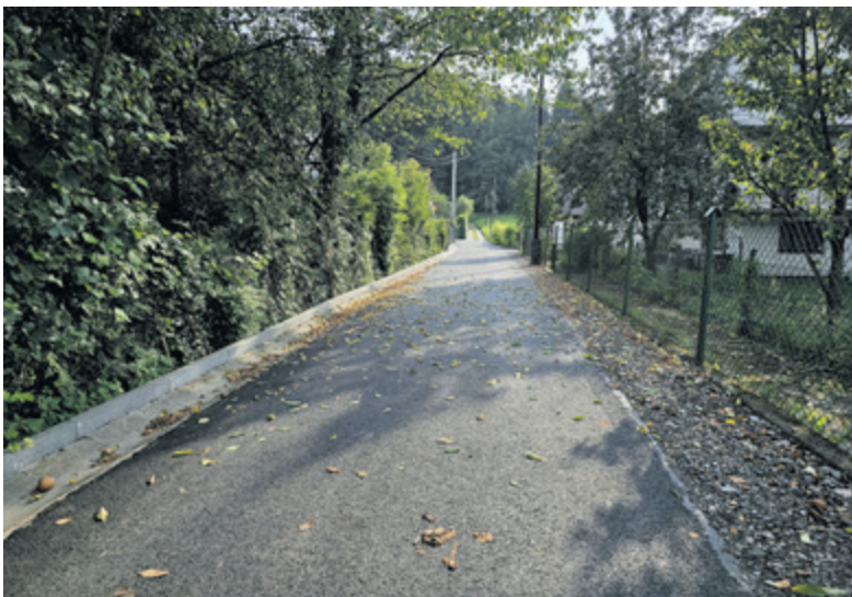
▲ W Huzelach, w ramach środków z Polskiego Ładu wykonane zostały dwie drogi. Pierwsza prowadzi w kierunku dawnego autozłomu, natomiast druga (na zdjęciu) na tzw. polanę
