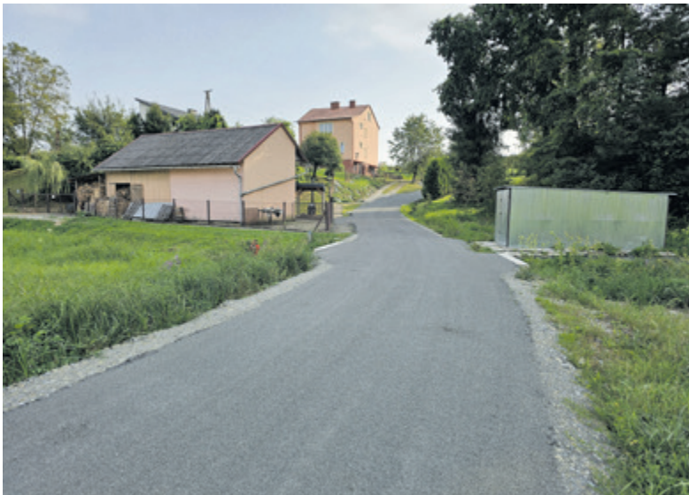
▲ Około 200. metrowy odcinek drogi gminnej wyremontowany został w Jankowcach. Po wykonaniu podbudowy z kryszywa, jako warstwę ścieralną zastosowano tam mieszkankę grysowo-smołową
