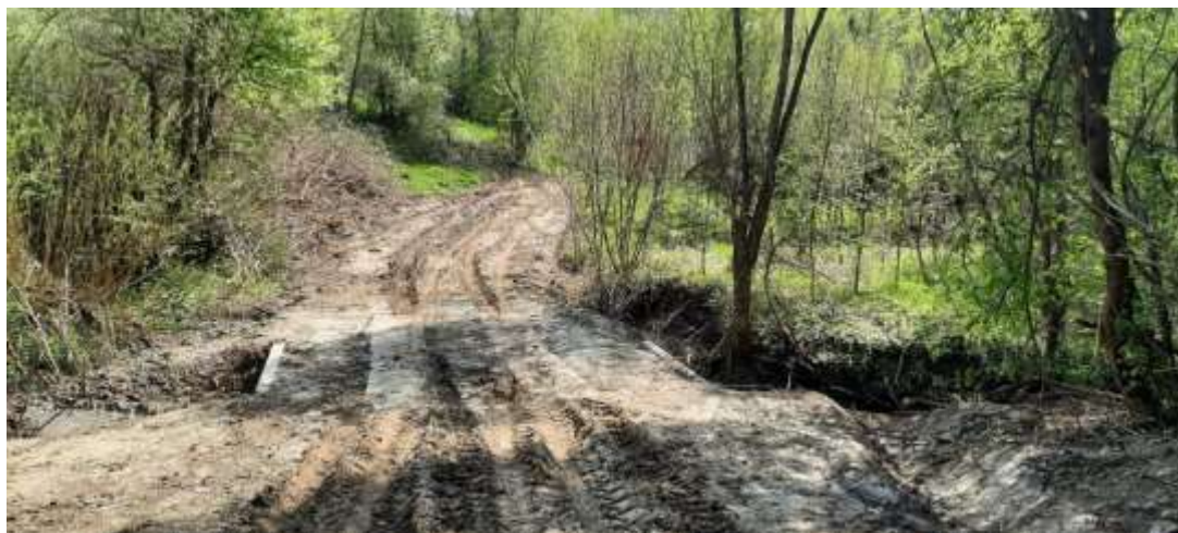
Przebudowa przepustu na drodze gminnej dz. nr ewid. 497 w m. Średnia Wieś
