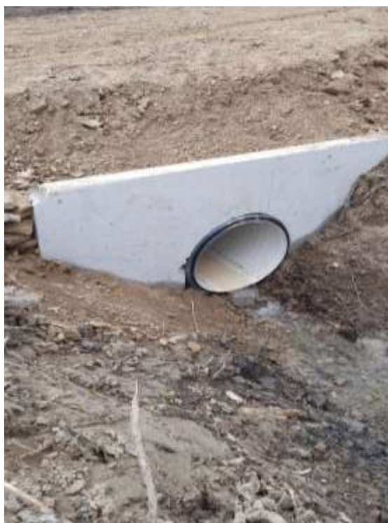
Przebudowa przepustu na drodze gminnej dz. nr ewid. 825 w m. Średnia Wieś
