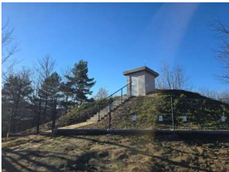
Zmodernizowany budynek techniczny na zbiorniku „Szopena” wraz z nowym ogrodzeniem
