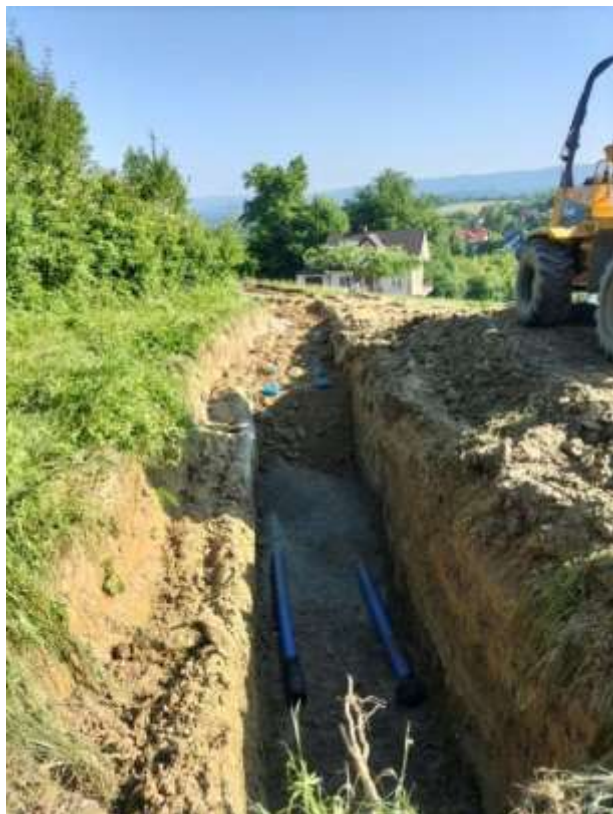
Sieć wodociągowa na ul. Szopena
