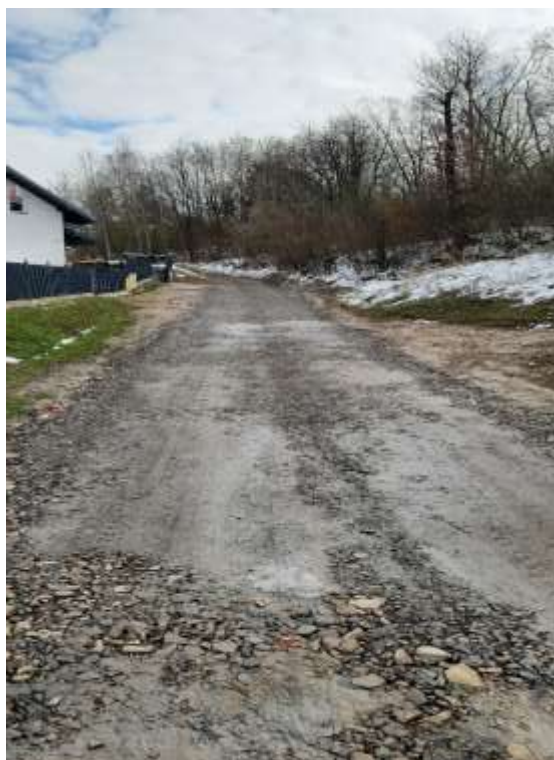
Remont nawierzchni z tłucznia kamiennego drogi gminnej dz. nr 87 w miejscowości Lesko
