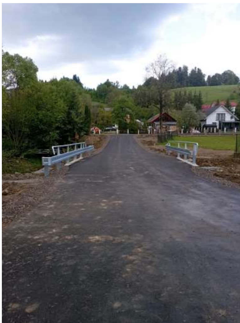
Budowa przepustu wraz z infrastrukturą techniczną w ciągu drogi wewnętrznej na dz. nr ew. 412 i 471 w miejscowości Bezmiechowa Dolna
