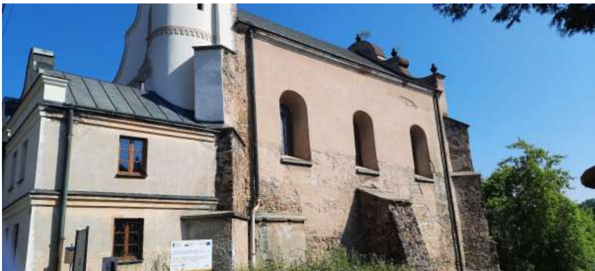
Lesko, budynek dawnej synagogi (XVII w.): prace konserwatorskie i roboty budowlane przy elewacji południowo-wschodniej
