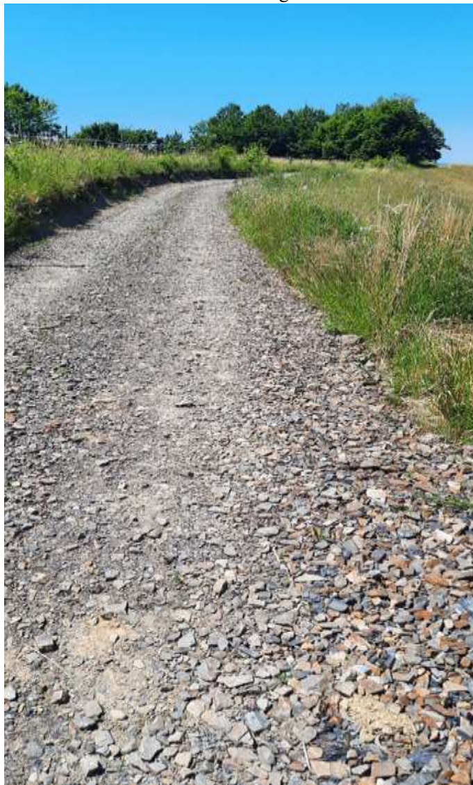
Przebudowa drogi gminnej dz. nr ewid. 193 w m. Weremień
