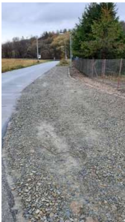
Przebudowa drogi gminnej na działkach ewid. nr 289, 293/1, 285, 286/2, 286/1, 287/3, 287/2, 287/1, 288 w miejscowości Łączki
