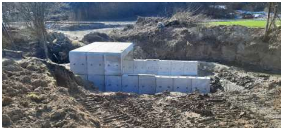
Budowa przepustu wraz z infrastrukturą techniczną w ciągu drogi wewnętrznej na dz. nr ew. 412 i 471 w miejscowości Bezmiechowa Dolna
