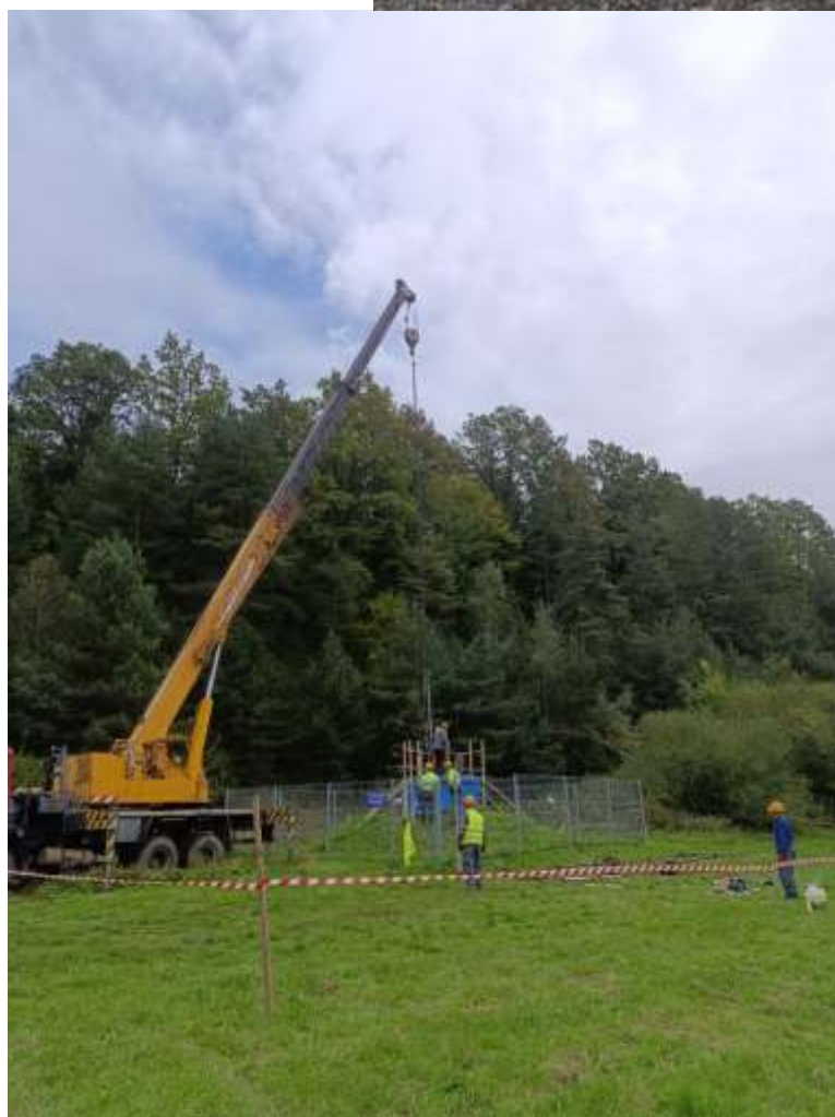
Wymiana pompy głębinowej studni S-10
