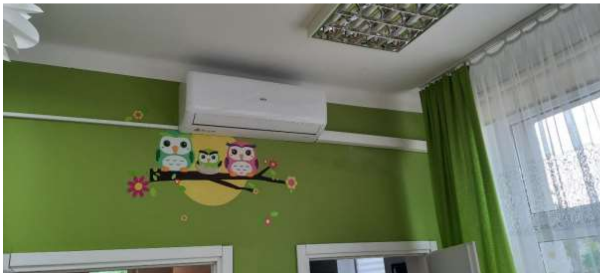
Dostawa i montaż systemu klimatyzacji dla sal przedszkolnych budynku Przedszkola Samorządowego im. Misia Uszatka w Lesku
