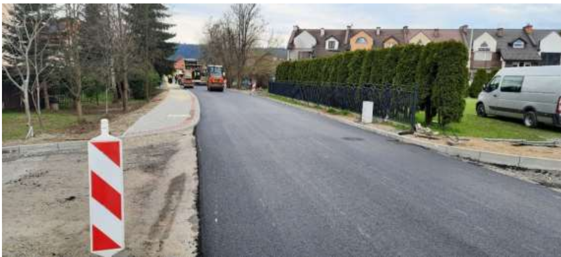
Przebudowa ul. Kwiatowej i ul. Jesionowej w Lesku wraz z budową chodnika
