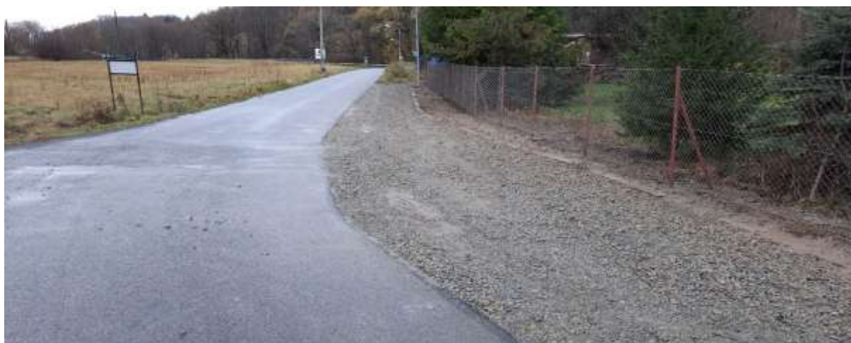
Przebudowa drogi gminnej na działkach ewid. nr 289, 293/1, 285, 286/2, 286/1, 287/3, 287/2, 287/1, 288 w miejscowości Łączki
