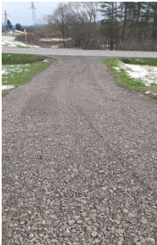
Remont nawierzchni z tłucznia kamiennego drogi gminnej dz. nr 174 w miejscowości Postolów
