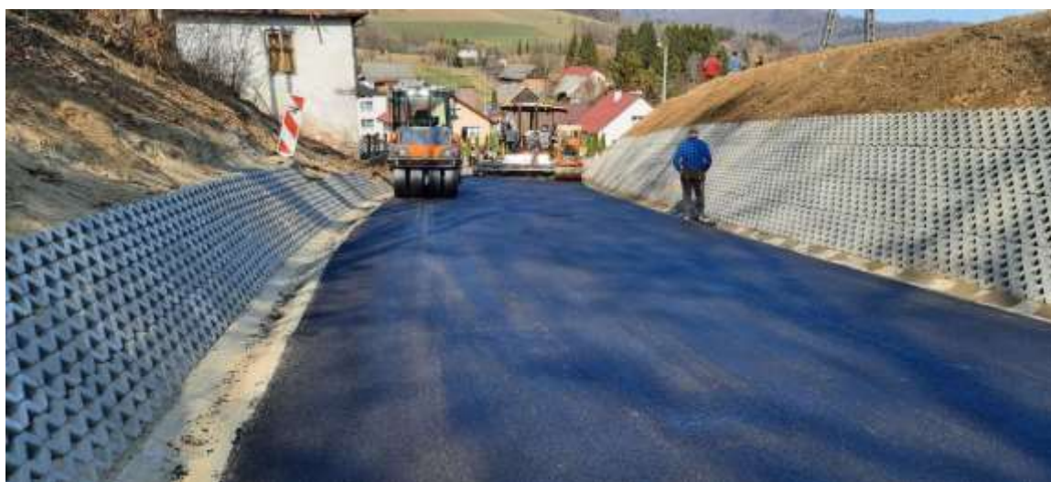
Przebudowa drogi gminnej na dz. 405, 339 w m. Hoczew
