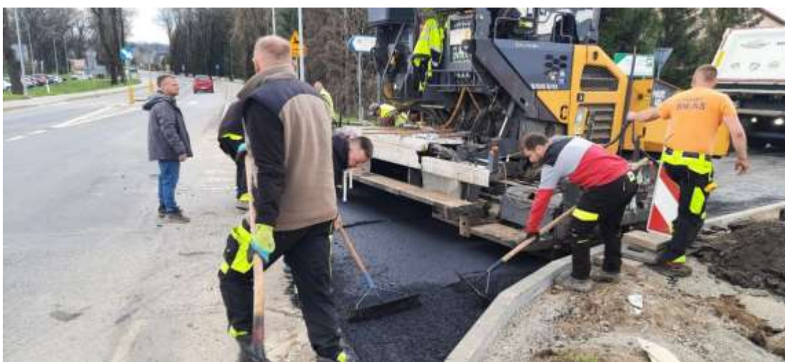
Przebudowa ul. Kwiatowej i ul. Jesionowej w Lesku wraz z budową chodnika
