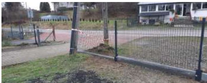
Wykonanie ogrodzenia dz. nr ewid. 47 na której znajduje się budynek świetlicy wiejskiej w m. Łukawica
