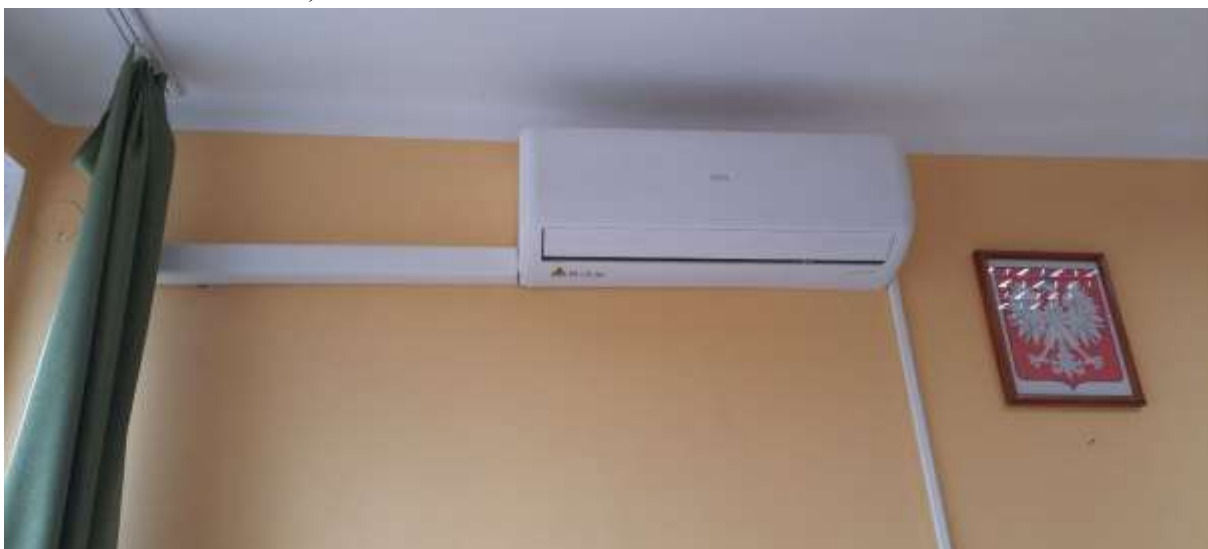
Dostawa i montaż systemu klimatyzacji dla budynku Przedszkola w Średniej Wsi
