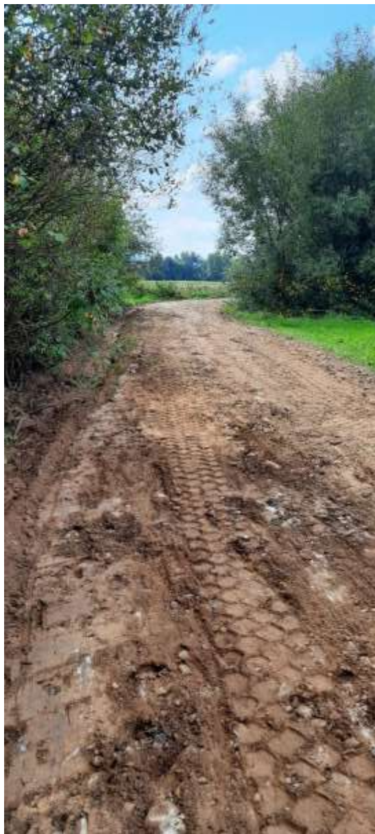
Remont nawierzchni w miejscowości Postolów na dz. nr 69
