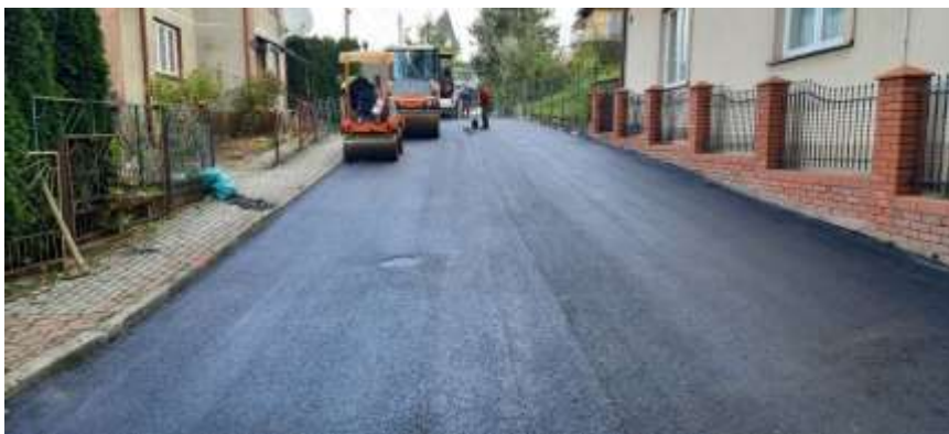
Remont ul. Grunwaldzkiej (118181R) w km 0+000 - 0+162 w Lesku
