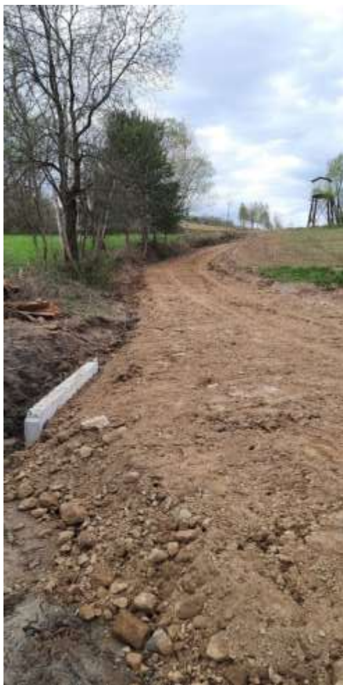
Przebudowa przepustu na drodze gminnej dz. nr ewid. 825 w m. Średnia Wieś
