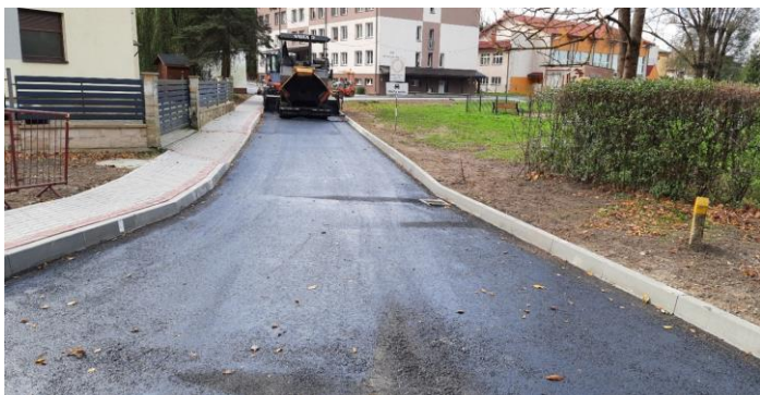
Zdjęcie 19 Remont nawierzchni drogi i ciągów pieszych na działkach nr 623/2, 627/2, 626/2 w miejscowości Lesko
