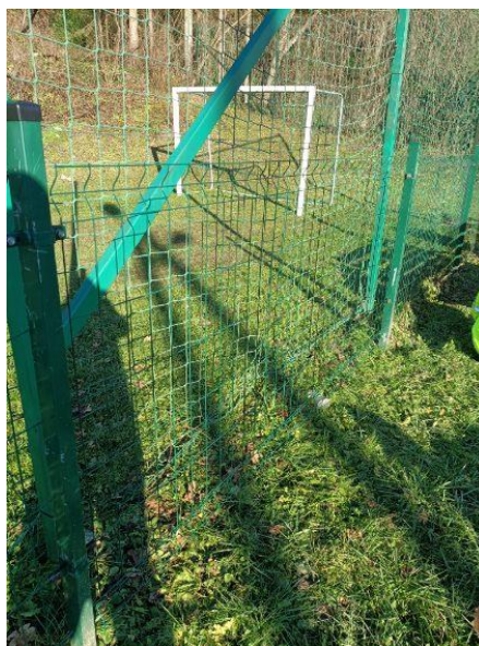
Zdjęcie 48 Zakup i montaż elementów huśtawki oraz naprawa ogrodzenia i ławki na placu zabaw w miejscowości Postolów
