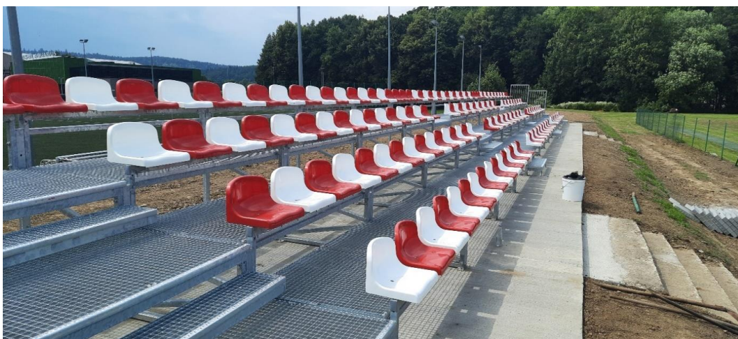
Zdjęcie 58 Modernizacja trybuny stadionowej poprzez jej wykonanie, dostawę oraz montaż
