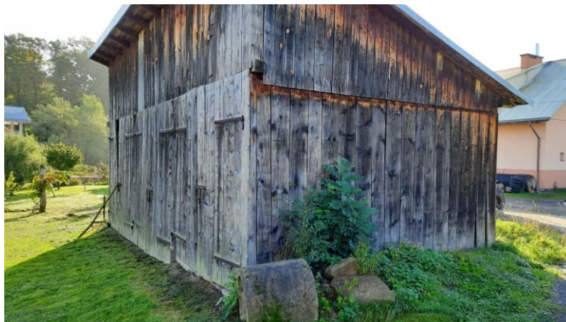
Zdjęcie 43 Rozbiórka budynku gospodarczego na działce nr ewid. 58/2 w miejscowości Bachława
