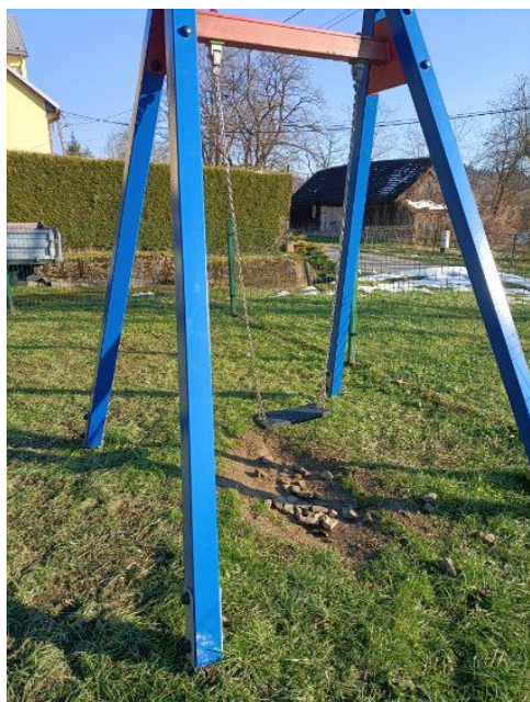
Zdjęcie 47 Zakup i montaż elementów huśtawki oraz naprawa ogrodzenia i ławki na placu zabaw w miejscowości Postolów
