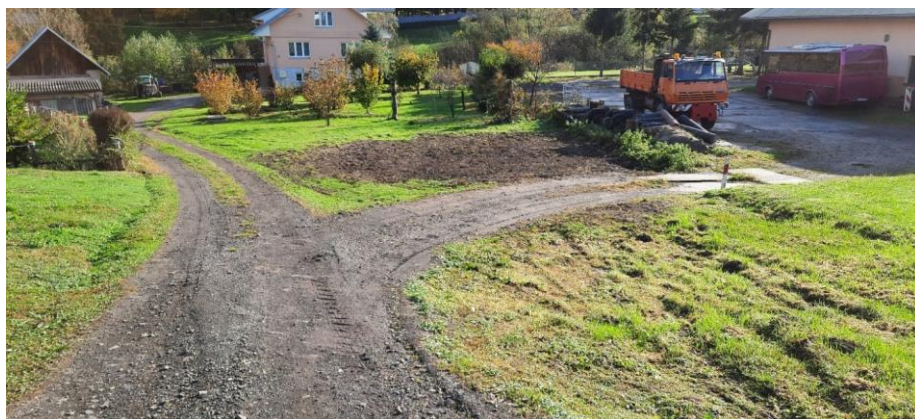
Zdjęcie 44 Rozbiórka budynku gospodarczego na działce nr ewid. 58/2 w miejscowości Bachława
