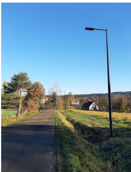
Zdjęcie 53 Budowa oświetlenia w ciągu drogi powiatowej Nr 2267R w m-ci Glinne.
