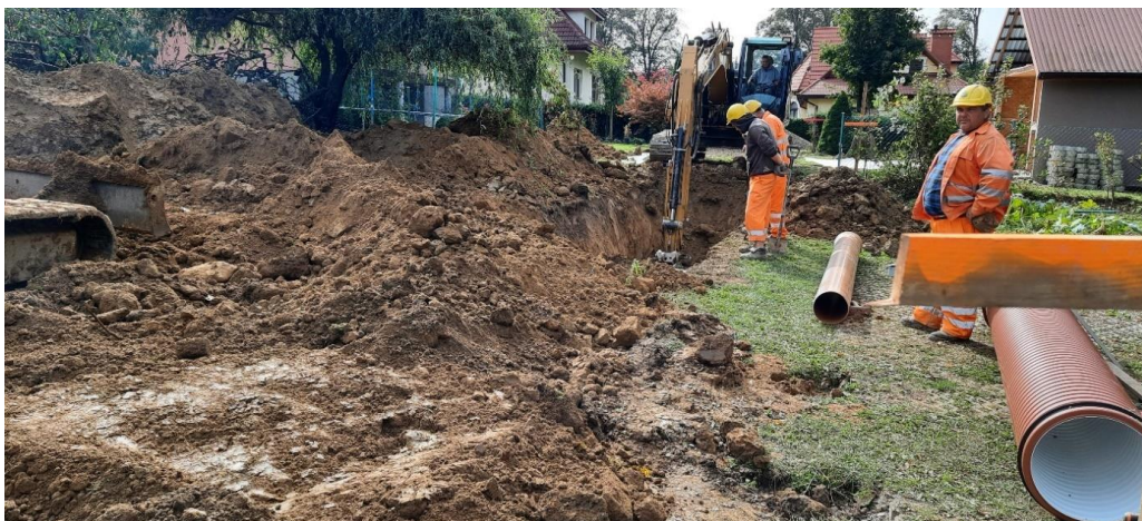
Zdjęcie 37 Remont infrastruktury wodociągowej, kanalizacji sanitarnej i kanalizacji deszczowej na terenach po byłym PGR w miejscowości Średnia Wieś - ETAP I
