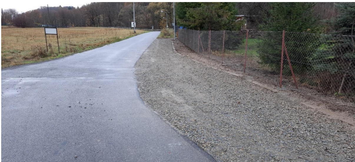
Zdjęcie 22 Poszerzenie odcinka drogi wewnętrznej gminnej dz. nr ewid. 289 w miejscowości Łączki
