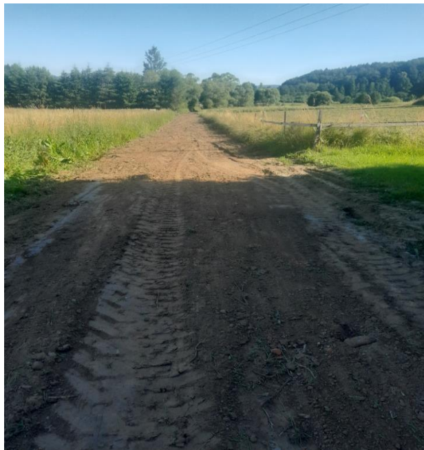
Zdjęcie 9 Prace remontowe w ciągu drogi gminnej dz. nr ewid. 346 i 375 w m-ci Łukawica
