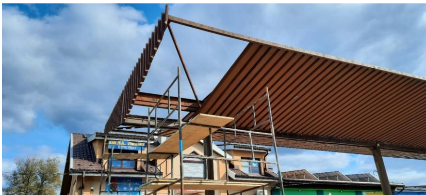
Zdjęcie 40 Budowa zadaszania na dworcu autobusowym w Lesku na dz. nr ewid. 1322/87 - Etap I
