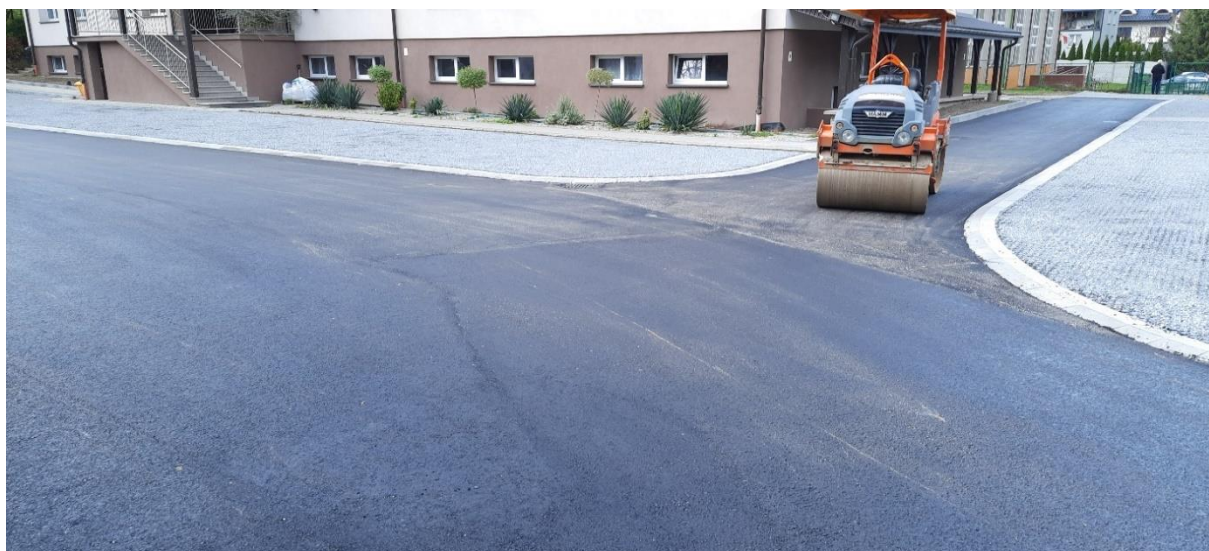
Zdjęcie 17 Remont nawierzchni drogi i ciągów pieszych na działkach nr 623/2, 627/2, 626/2 w miejscowości Lesko
