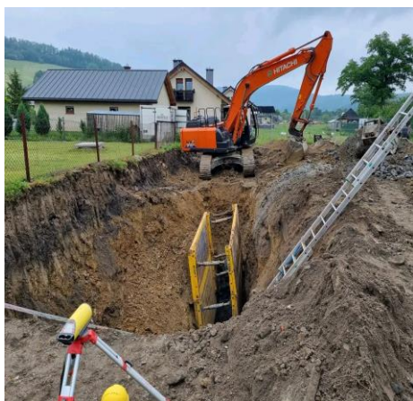
Zdjęcie 34 Budowa sieci kanalizacji sanitarnej w Hoczwi na lewym brzegu rzeki Hoczewka do przejścia przez drogę wojewódzką nr 894 wraz z przepompownią P4
