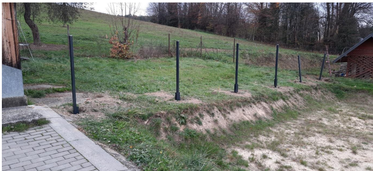
Zdjęcie 45 Wykonanie ogrodzenia placu zabaw przy świetlicy wiejskiej w miejscowości Dziurdziów
