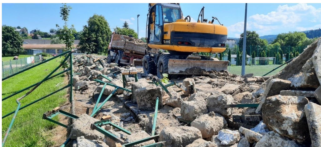
Zdjęcie 56 Modernizacja trybuny stadionowej poprzez jej wykonanie, dostawę oraz montaż
