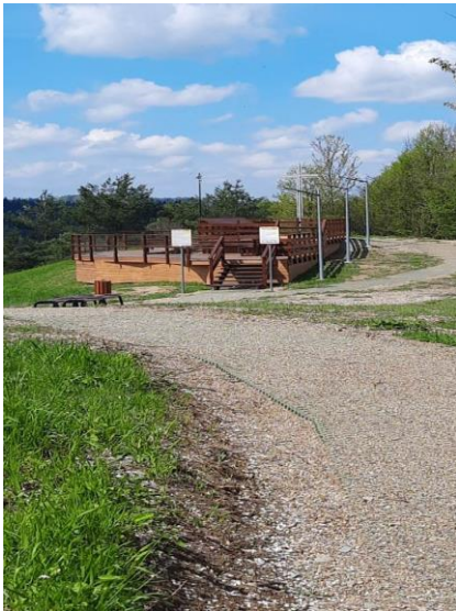
Zdjęcie 59 -62 Budowa tarasu widokowego, ścieżki turystycznej oraz oświetlenia zewnętrznego wraz z elementami małej architektury na działce nr 1167/1 w Lesku
