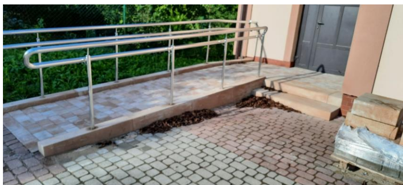
Zdjęcie 31 Remont schodów wejściowych do budynku WDK Łukawica
