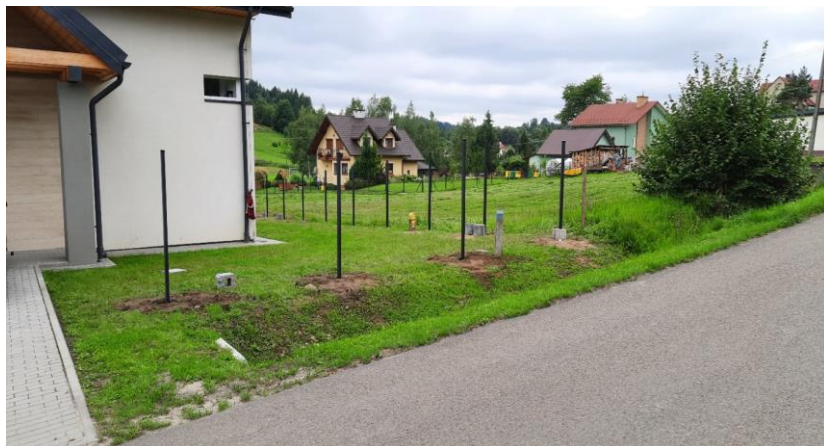
Zdjęcie 27 Roboty budowlane obejmujące zagospodarowanie terenu wokół świetlicy wiejskiej w Jankowcach poprzez budowę ogrodzenia
