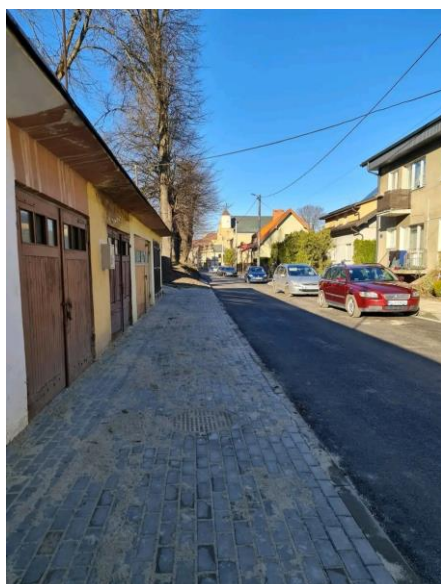
Zdjęcie 24 Przebudowa drogi nr 118191R (ul. Berka Joselewicza) w Lesku
