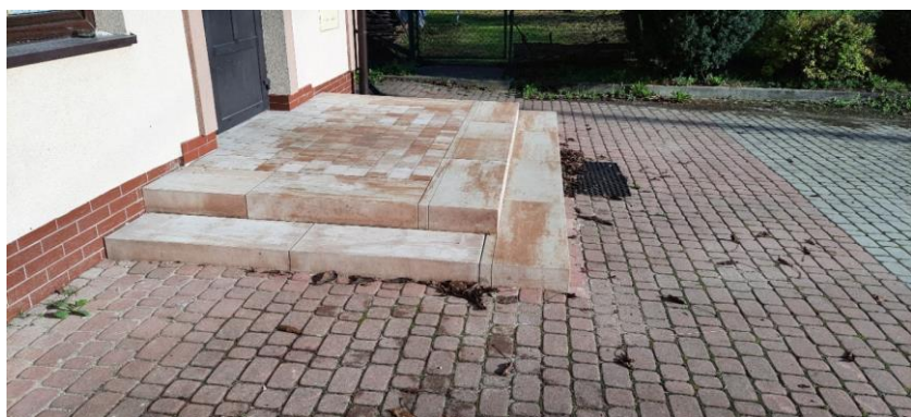
Zdjęcie 30 Remont schodów wejściowych do budynku WDK Łukawica
