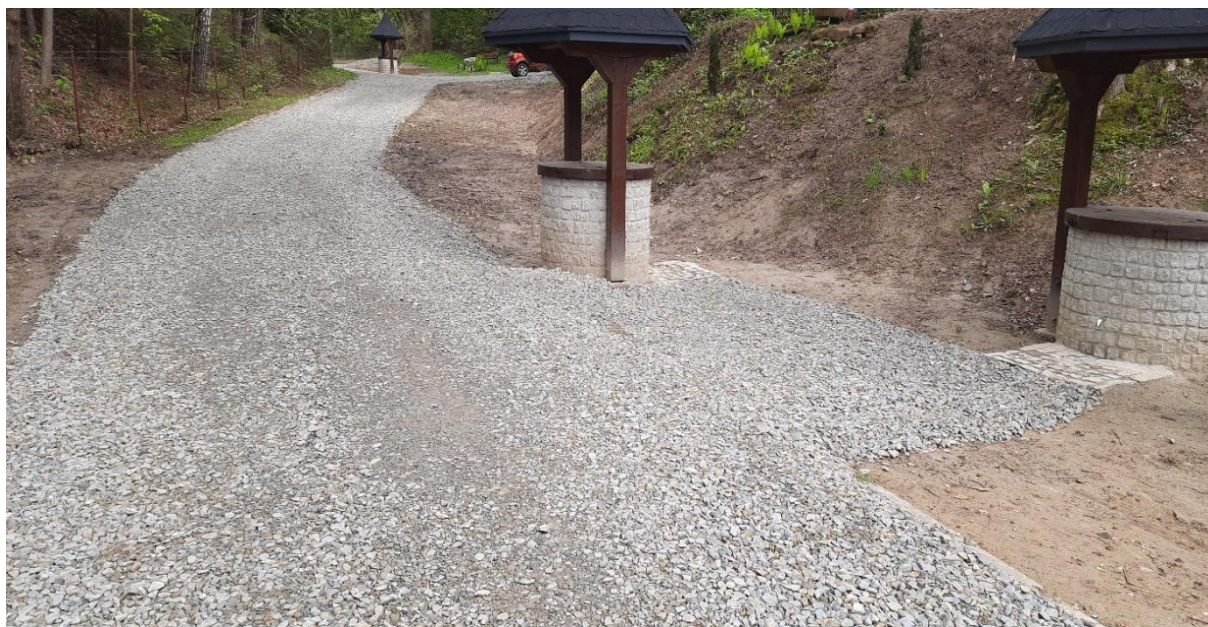
Zdjęcie 7 Remont nawierzchni drogi gminnej (ul. Źródłana) na działce nr ew. 237/5 w Lesku
