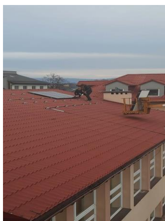
Zdjęcie 49 Dostawa i montaż instalacji fotowoltaicznej na UMiG Lesko
