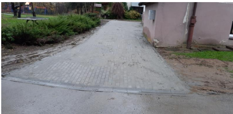
Zdjęcie 21 Wykonanie odcinka drogi na terenie szkoły i chodnika do placu zabaw w miejscowości Manasterzec
