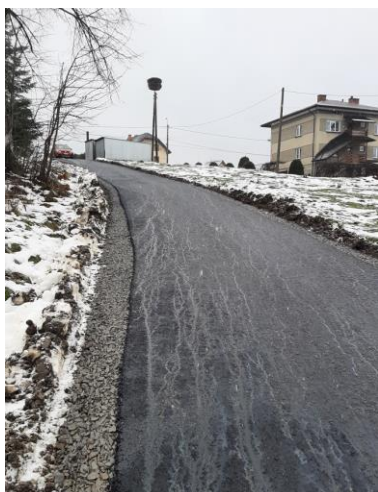
Zdjęcie 13 Modernizacja drogi wewnętrznej na dz. nr ew. 91 w m. Weremień
