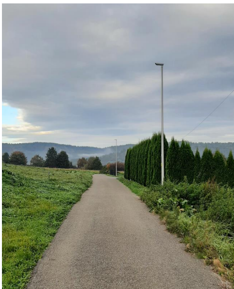
Zdjęcie 52 Budowa oświetlenia w ciągu drogi gminnej dz. nr ew. 269 w m-ci Huzele. Budowa oświetlenia ulicznego w miejscowości Glinne
