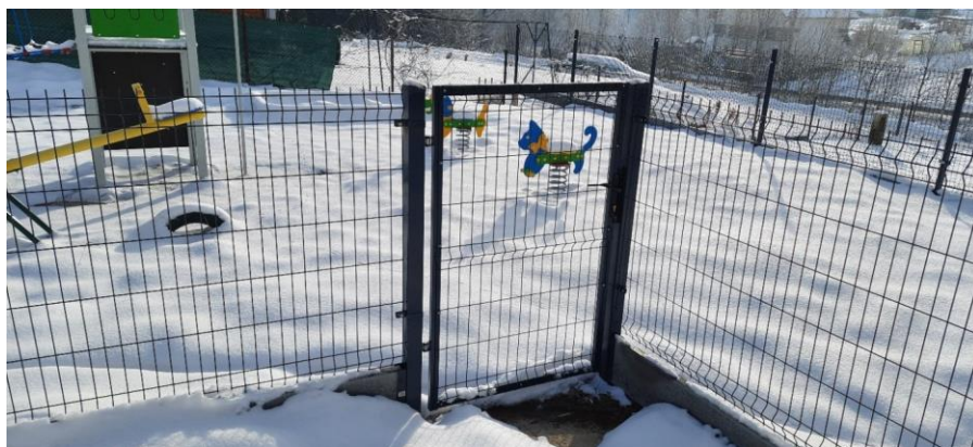
Zdjęcie 46 Wykonanie ogrodzenia placu zabaw przy świetlicy wiejskiej w miejscowości Dziurdziów
