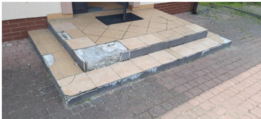
Zdjęcie 29 Remont schodów wejściowych do budynku WDK Łukawica
