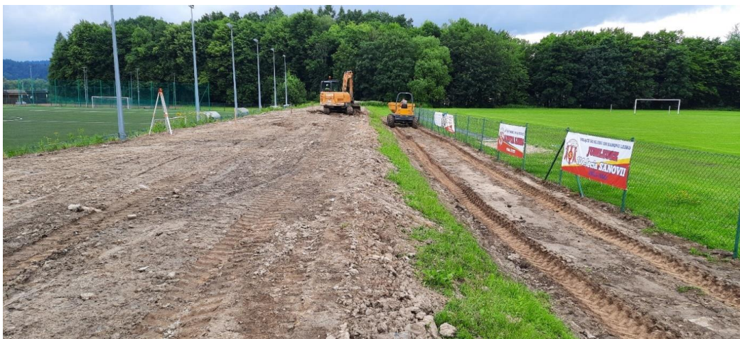
Zdjęcie 57 Modernizacja trybuny stadionowej poprzez jej wykonanie, dostawę oraz montaż
