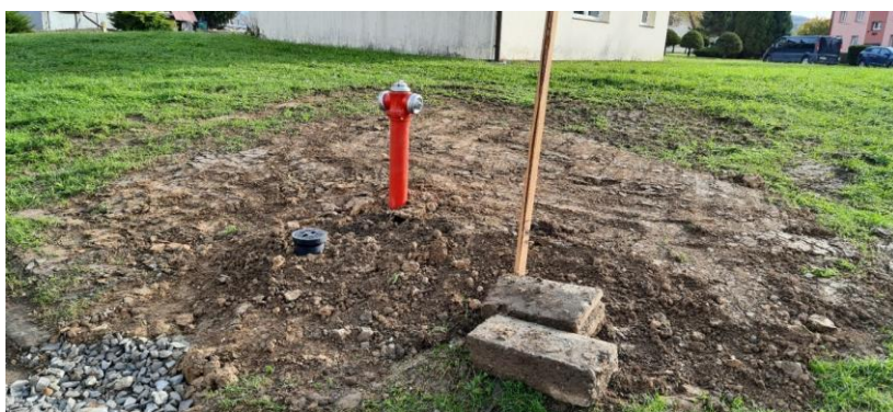
Remont infrastruktury wodociągowej, kanalizacji sanitarnej i kanalizacji deszczowej na terenach po byłym PGR w miejscowości Średnia Wieś - ETAP I
