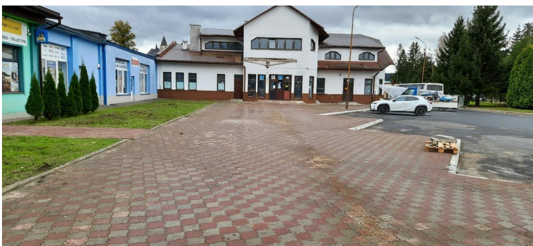
Zdjęcie 41 Budowa zadaszania na dworcu autobusowym w Lesku na dz. nr ewid. 1322/87 - Etap I
