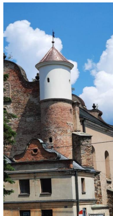
Zdjęcie 26 Renowacja wieżyczki - baszty w elewacji południowo- zachodniej budynku dawnej synagogi w Lesku
