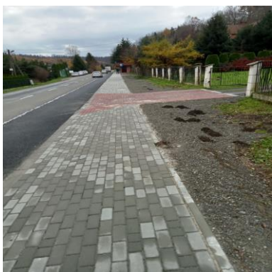
Zdjęcie 2 Budowa i modernizacja drogi dojazdowej do gruntów rolnych w obrębie Huzele, dz. o nr ewid. 311.
