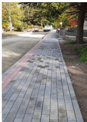
Zdjęcie 18 Remont nawierzchni drogi i ciągów pieszych na działkach nr 623/2, 627/2, 626/2 w miejscowości Lesko
