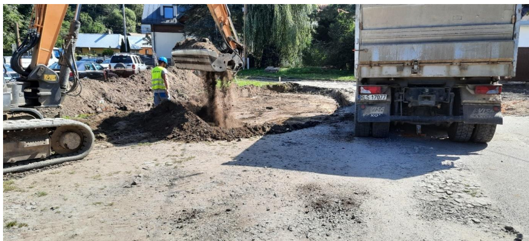
Zdjęcie 16 Utwardzenie terenu na nieruchomościach położonych przy ul. Wincentego Pola w Lesku
