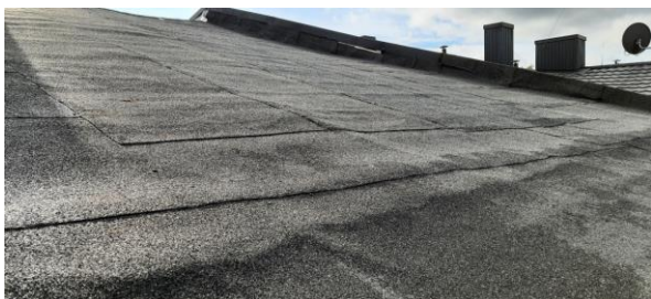
Zdjęcie 42 Remont pokrycia dachu budynku przy ul. Rynek 18 w Lesku
