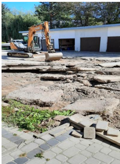
Zdjęcie 14 Utwardzenie terenu na nieruchomościach położonych przy ul. Wincentego Pola w Lesku
