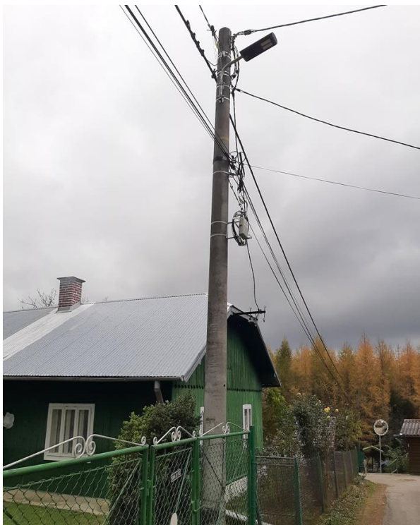
Zdjęcie 54 Podwieszenie opraw oświetleniowych na słupach linii nN w ciągu drogi wewnętrznej na dz. nr ew. 433 w m-ci Glinne.
