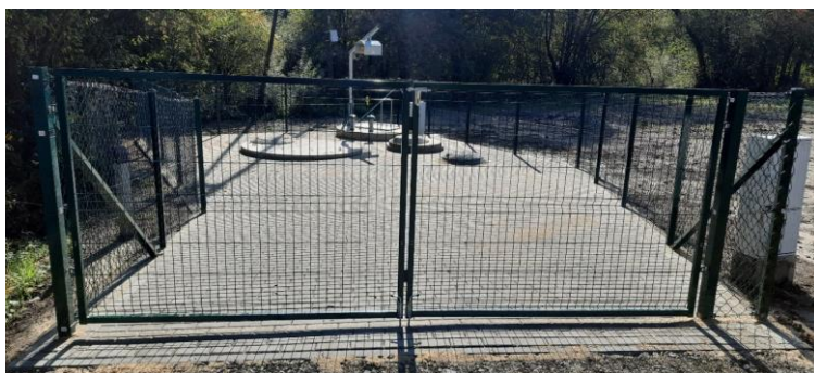
Zdjęcie 35 Budowa sieci kanalizacji sanitarnej w Hoczwi na lewym brzegu rzeki Hoczewka do przejścia przez drogę wojewódzką nr 894 wraz z przepompownią P4
