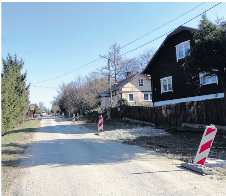
▲ Zdjęcie ul. Widokowej w trakcie prowadzonych prac
