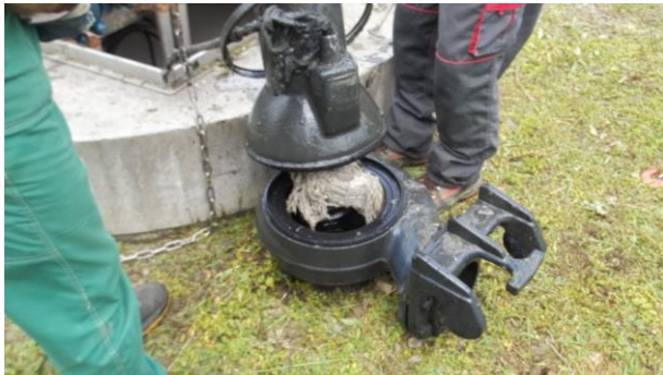
Zablokowanie pompy materiałami nieprzechodzącymi przez wirnik widoczne na powyższym zdjęciu, skręcone w warkocz (mopy, chusteczki nawilżone, podpaski itp.)
