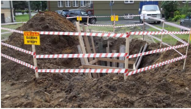
Głębokie wykopy przy usuwaniu awarii na sieci wodociągowej
