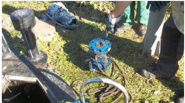
Zatkany kolektor przesyłowy w przepompowni ścieków
