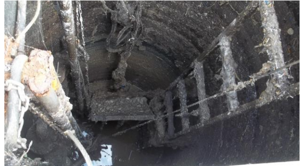
Czyszczenie przepompowni
