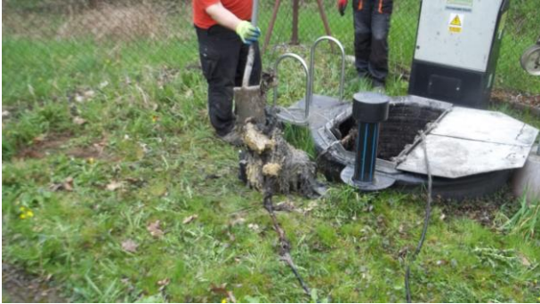
Materiały wyciągnięte z przepompowni ścieków, które spowodowały zatrzymanie całkowite przepompowni, co wiązało się z wylaniem ścieków na sieci przesyłowej (zalanie posesji, budynków mieszkalnych, podpiwniczeń)
