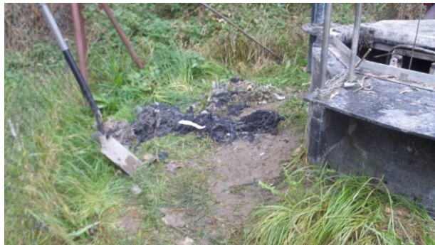
Materiały wyciągnięte z przepompowni (kamienie itp.)
