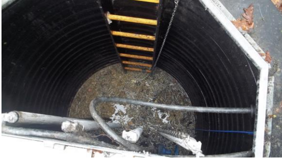
Zatrzymanie przepompowni ścieków
