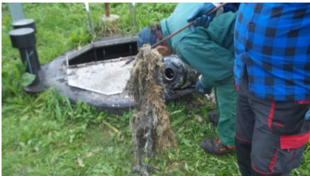
Materiały wyciągnięte, które spowodowały zablokowanie wirników pomp i zatrzymanie pracy całej przepompowni
