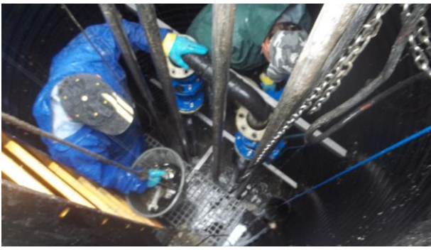
Praca pracowników w przepompowni - czyszczenie, mycie, udrażnianie zaworów
