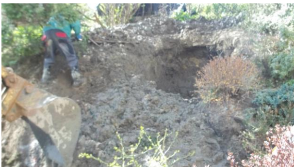
Awaria sieci wodociągowej
